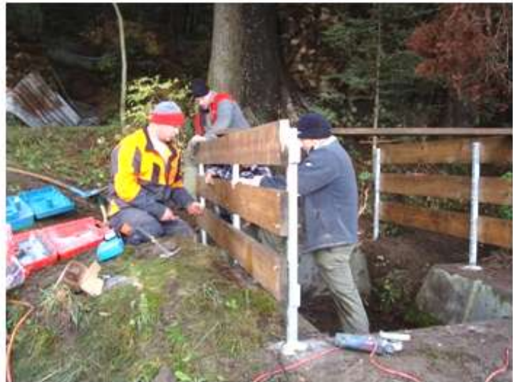
Ein neues Geländer montieren
