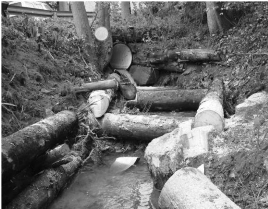
Die Bachsohle anheben mit Riegeln und Schwellen um die Auslaufhöhe zu reduzieren
