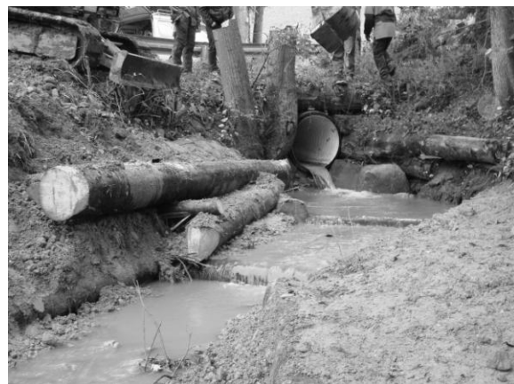
Die Bachsohle anheben mit Riegeln und Schwellen um die Auslaufhöhe zu reduzieren
