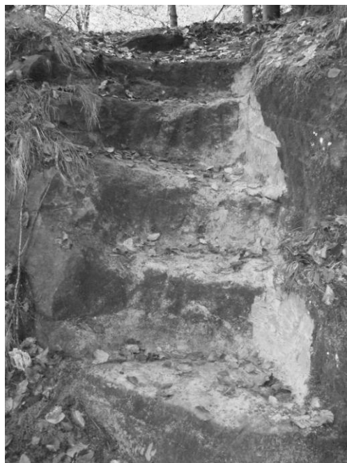
Stufen im Sandstein gereinigt und nachgearbeitet
