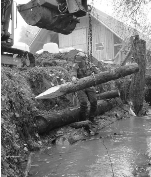
Bachufer verbauen mit grobem Material wie Schwellen und Zangen
