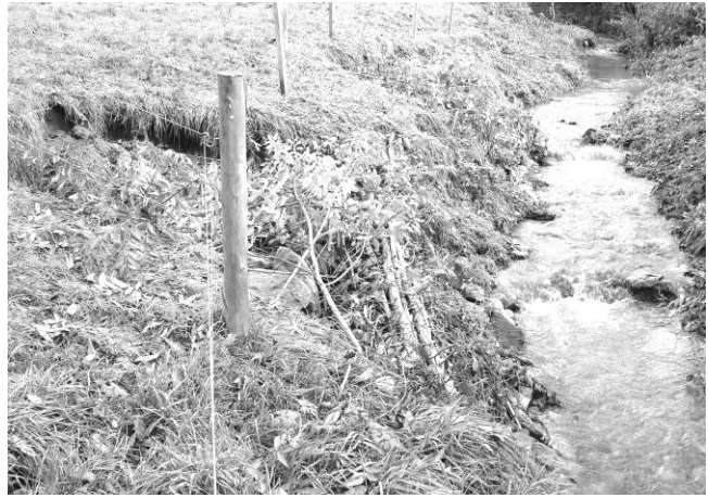
Bachufer mit Faschinen gesichert.
