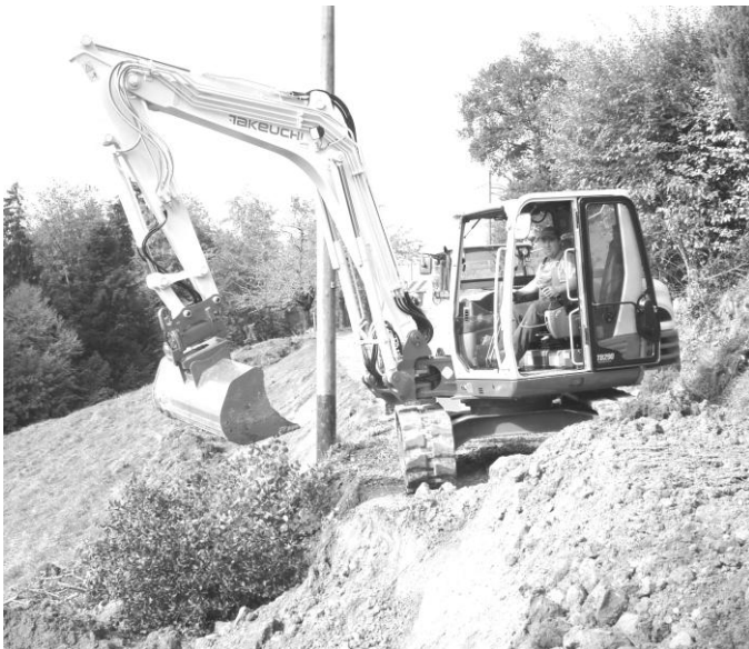
Gearbeitet wurde mit Bagger,
