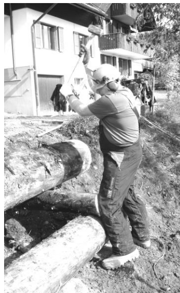
Abbauhammer oder Steinschlegel für die Schwelennägel und die altbewährte Grienschaufel
