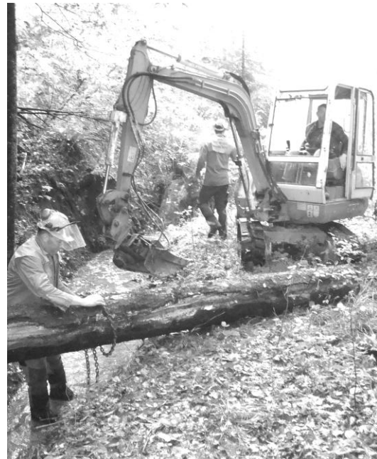
Die Schwellen wurden mit den Traktoren zugeführt und mit dem Bagger eingesetzt.
