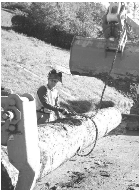
Die Schwellen wurden mit den Traktoren zugeführt und mit dem Bagger eingesetzt.
